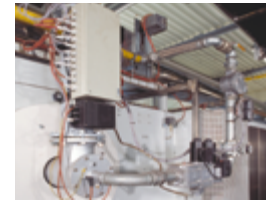
Edelstahlschläuche in Versorgungsleitungen von Gebäuden.
