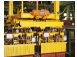
Edelstahlschläuche und -kompensatoren am Ofen in der Ziegelbrennerei.
