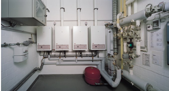
DL Druckwächter sichert jeden Abgasweg in der Kaskarde ab
